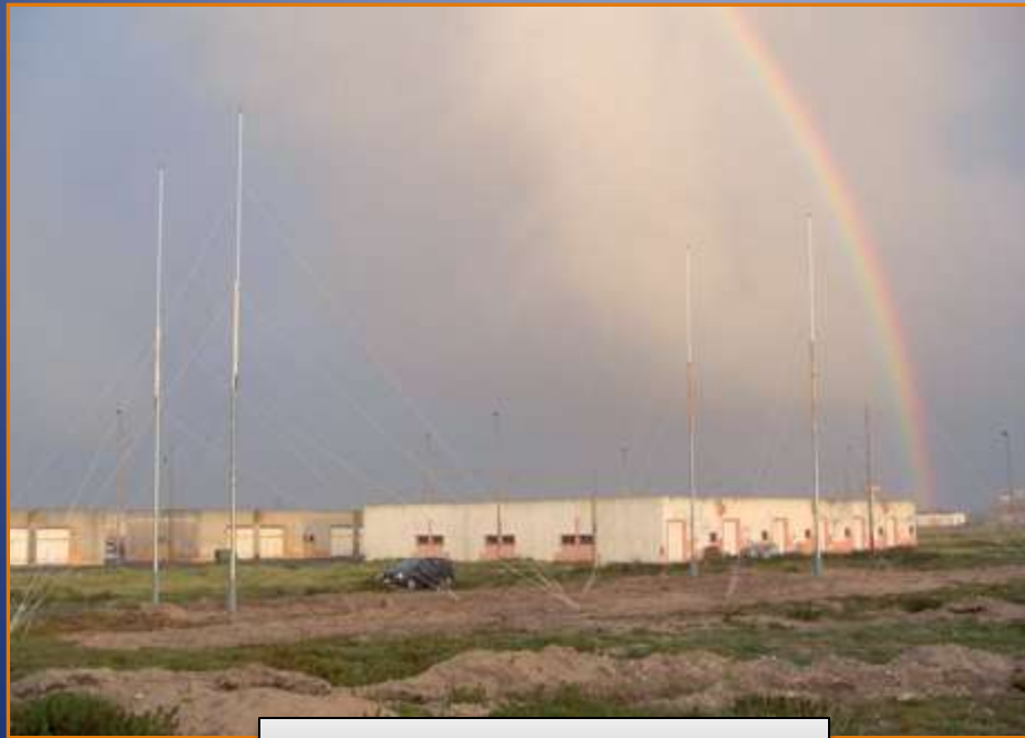
TX Antenna Array
